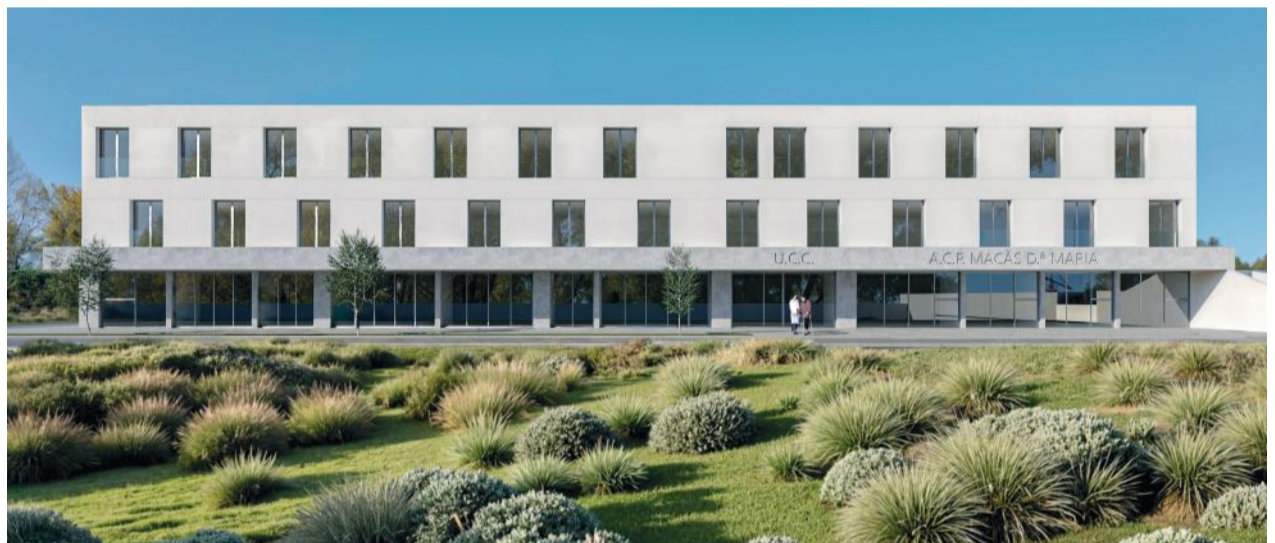
Futura Unidade de Cuidados Continuados de Maçãs de D. Maria fica concluída no verão de 2026
